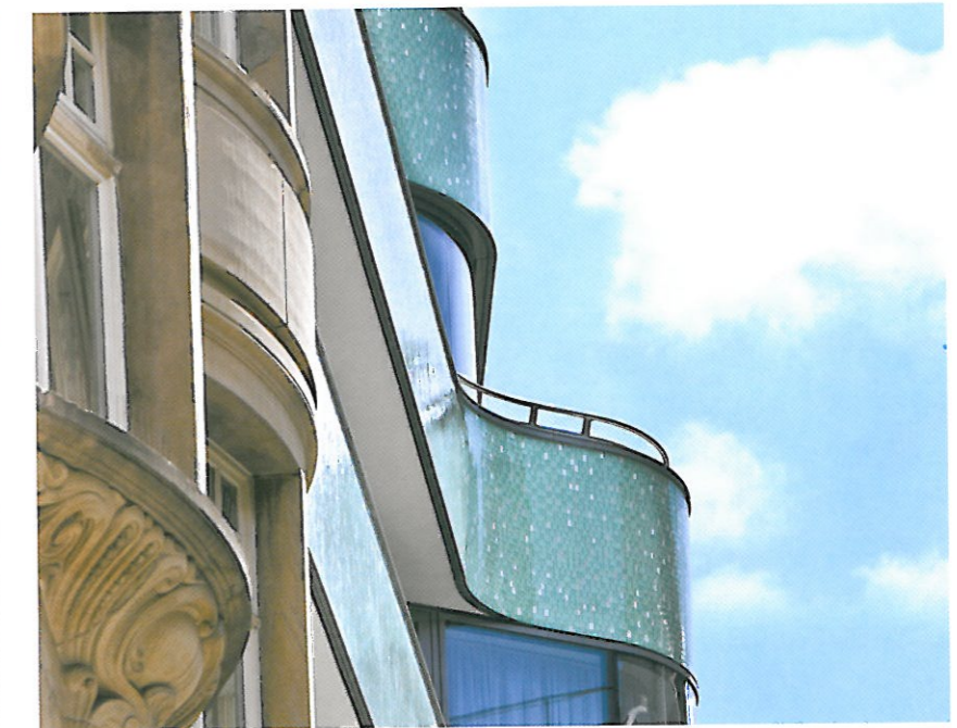
Die geschwungene Fassade fügt sich in die städtebauliche Situation und schafft eine gelungene Anbindung an die Nachbarbebauung.
